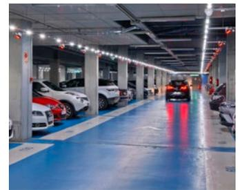
Sistema de guiado e iluminación LED regulada para reducir el consumo de energía y el tiempo para aparcar.
